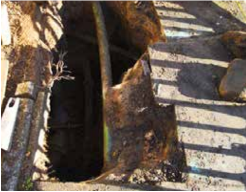
Absturzgefahr bei kleiner Baugrube in der Straße.
