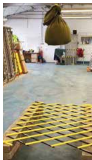
Die Gittermatte wird ausgezogen, so dass es eine Sicherheitsabdeckung über der Aufgrabung bildet. Clips sorgen für zusätzliche Stabilität werden.
