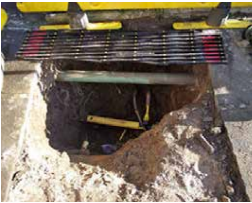
Die geschlossene Gittermatte wird über ein Ende der offenen Aufgrabung gelegt.
