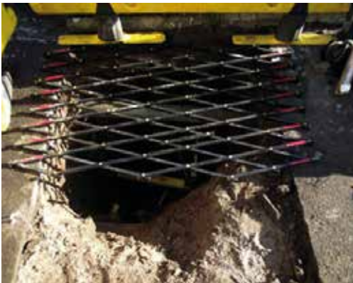
Die Gittermatte wird ausgezogen, so dass es eine Sicherheitsabdeckung über der Aufgrabung bildet. Clips sorgen für zusätzliche Stabilität werden.
